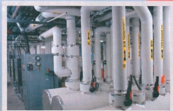
La « salle des machines », c'est l'endroit où parviennent les fluides parcourant la quarantaine de puits géothermiques servant à climatiser l'édifice. C'est également l'endroit où se trouve une série de réservoirs d'huile servant à la lubrification des véhicules : une façon efficace et écologique de procéder.
